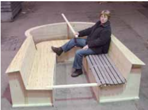
De kuip werd eerst in hout gemaakt, na wat aanpassingen werden de maten overgebracht in het definitieve ontwerp.
